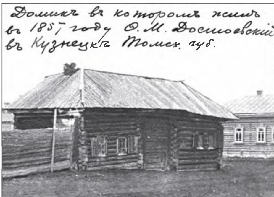
Рис. 8. Двойная связь сибирского типа на Подгорье. В этом домике останавливался Ф.М. Достоевский в 1857 г. Фото нач. XX в.
