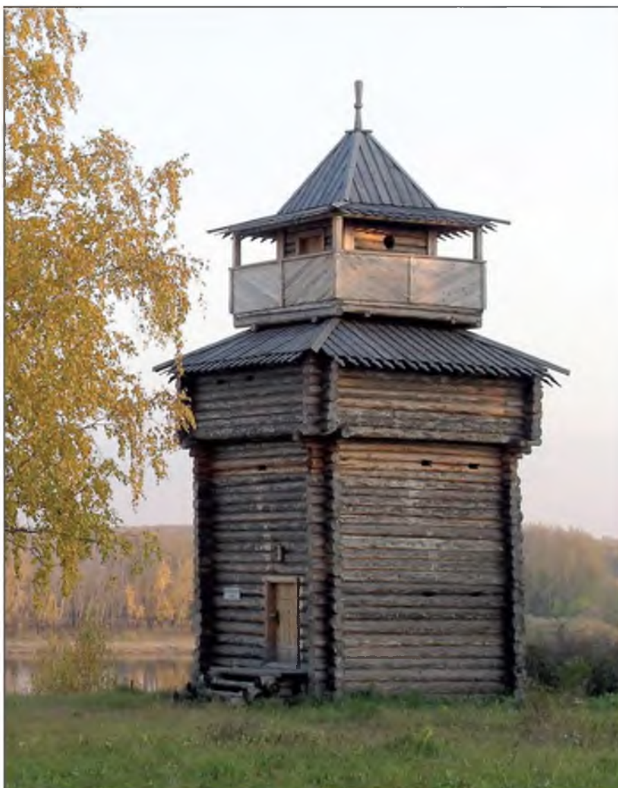
Рис. 2. Реконструкция острожной башни XVII в. (Бельского острога) на территории экомузeya «Тюлюберский городок» в Кемеровском районе
