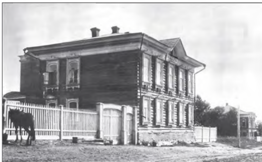
Рис. 20. Будущая ул. Водопадная. На переднем плане здание Тельбесбюро (бывший «дом Абрамова»). Фото 1926 г.
